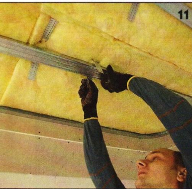
Подвесы устанавливал с меньшим, чем обычно, шагом, чтобы обеспечить запас прочности конструкции.
