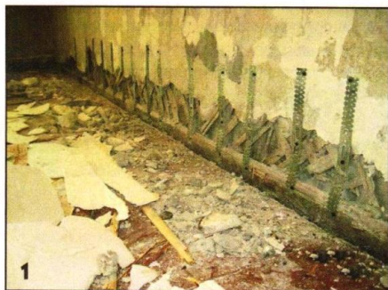
1 Прямые подвесы пригодились при ремонте стен.
