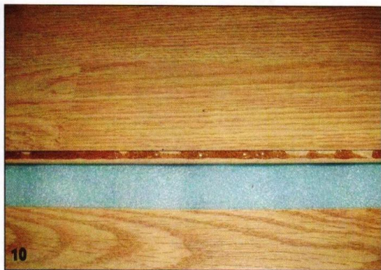
10 При использовании клея его наносят на нижнюю полку паза.
