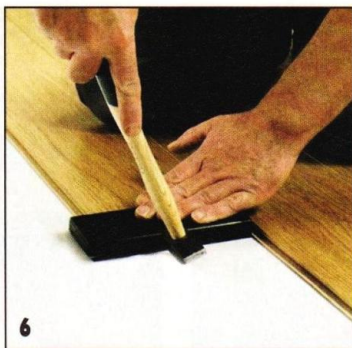
6 Чтобы между досками не осталось даже небольших щелей, при стыковке доски подбивают лёгким постукиванием молотка по кромке через подкладку.
