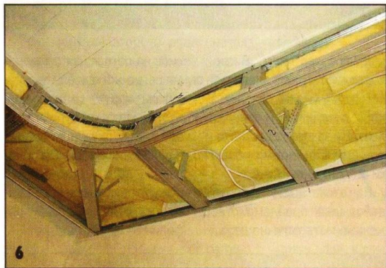
Поверх ваты проложил электропроводку для подключения подсветки потолка и установил поддерживающие элементы каркаса.
