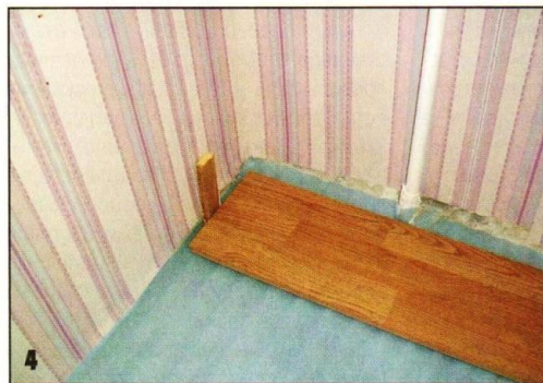
6 Чтобы между досками не осталось даже небольших щелей, при стыковке доски подбивают лёгким постукиванием молотка по кромке через подкладку.
