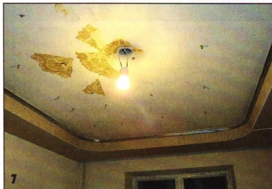
Периферическая часть потолочной конструкции обшита гипсокартоном.
