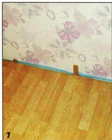
7 По всему периметру комнаты в зазор между стеной и краем ламинированного покрытия устанавливают клинья.
