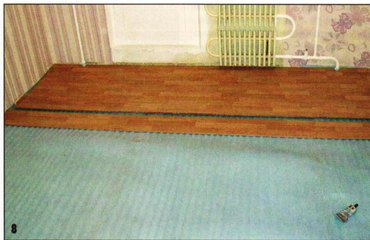
8 При монтаже каждого ряда сначала стыкуют все торцевые замки, а потом, когда ряд будет собран, готовую половицу вставляют в продольный замок предыдущего ряда.
