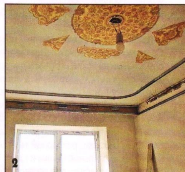
Профили к потолочной плите и стенам крепили через демпферную ленту.
