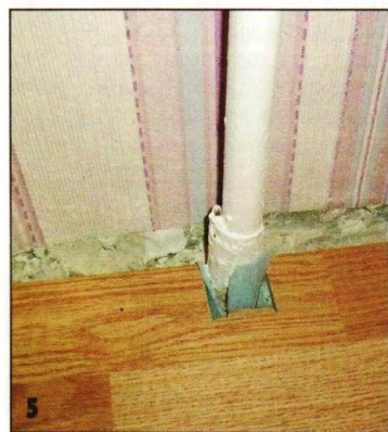
5 В местах выхода труб в ламинированном покрытии делают вырезы с учётом зазора в 10–15 мм.
