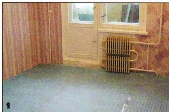
Полосы подложки склеивают друг с другом самоклеящейся лентой.
