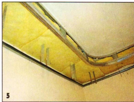
Когда каркас на периферической части потолочной плиты был смонтирован, заполнил его минеральной ватой.
